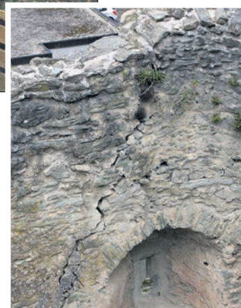
Stefanie Münch erklärt, wie der Druck abgeleitet wird (oben). Einer der Risse auf der Rückseite der Mauer (re.).
